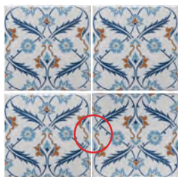
Dit is onjuist, want de patronen aan de zijanten sluiten niet op elkaar aan, aangezien de tegel rechtsonder ondersteboven is aangebracht
